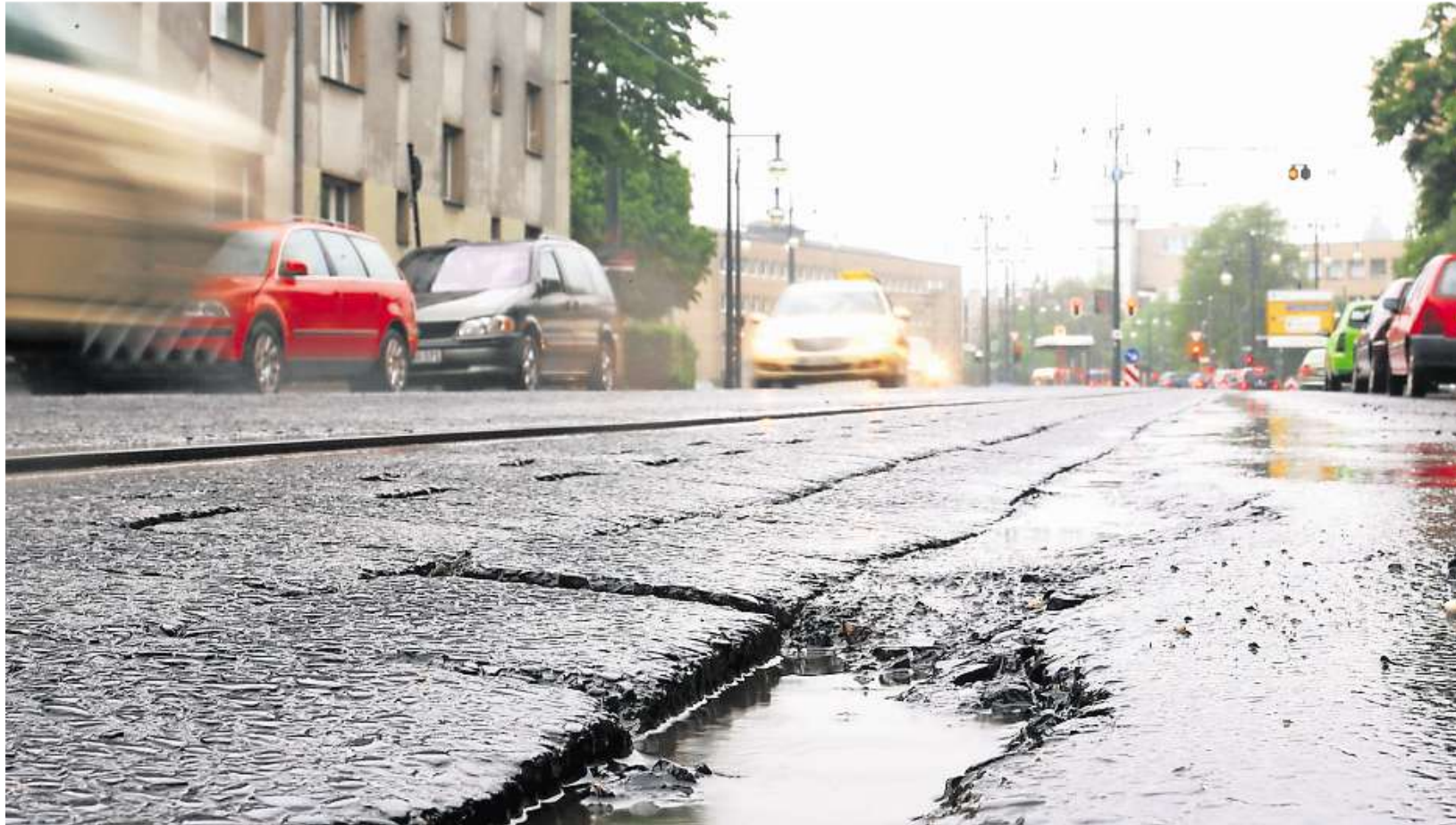
Der Umbau der Philadelphiastraße soll im Herbst beginnen und bis Ende 2026 dauern. Der erste politische Auftrag dazu erging im Jahr 2000 in der Bezirksvertretung Mitte.
