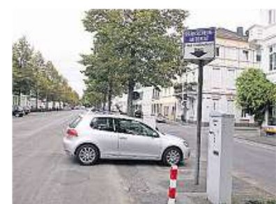
Mitarbeiter des KBK errichten in Uerdingen Parkscheinautomaten FOTO: TL
